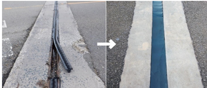
「ゴム劣化取替工法」【NETIS QS-180049-A】
