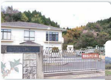
郡家浄化センター
