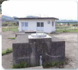
久能寺 第二水源地
