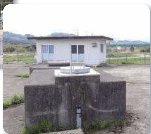
久能寺 第二水源地
