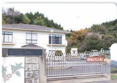
郡家浄化センター
