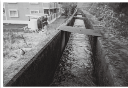
崩壊前の状況
