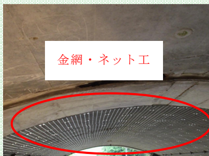
写真2.3 金網・ネット工の事例
