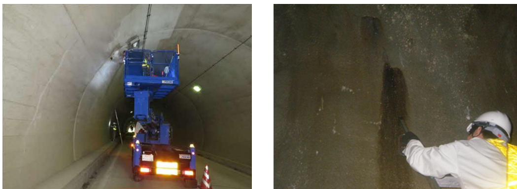
写真2.1 点検状況写真（トンネル定期点検）
