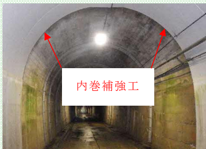
写真2.2 内巻補強工の事例
