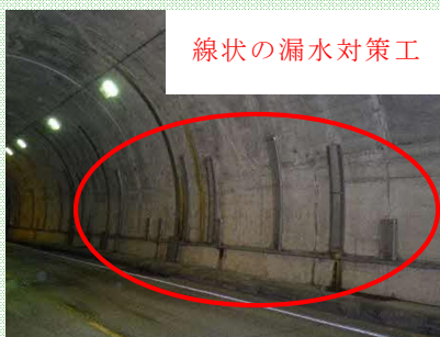
写真2.4 線状の漏水対策工の事例
