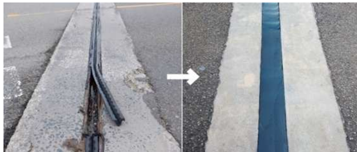
「ゴム劣化取替工法」【NETIS QS-180049-A】
