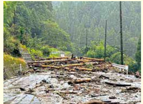
土砂流出により寸断された道路
