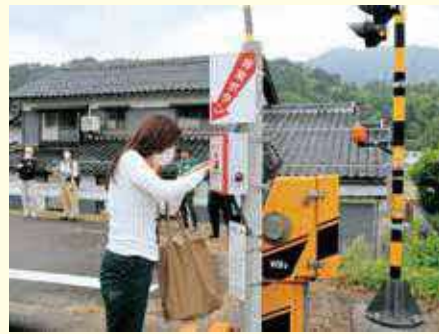
押すのに力がある踏切非常ボタン
