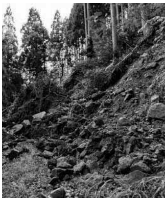
災害にあった森林作業路網 (落岩)
