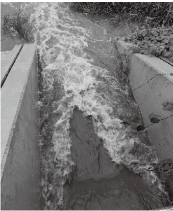
完成した公共下水道 竹の下排水口
