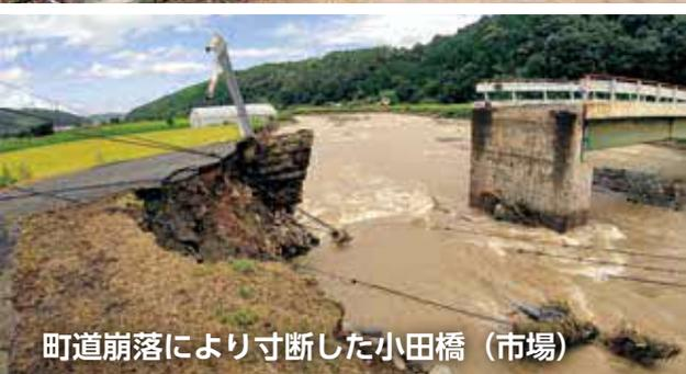
町道崩落により寸断した小田橋（市場）
