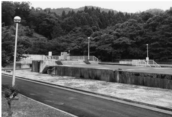
八頭町公共下水道郡家浄化センター
