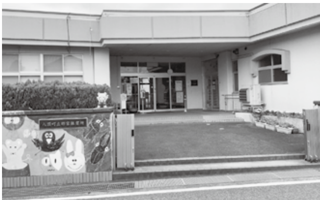
スロープ設置が望まれる郡家保育所
