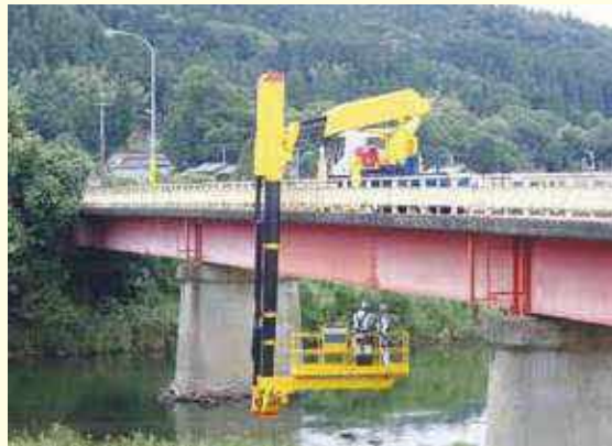
▲毎年約50橋の点検を実施しています。
