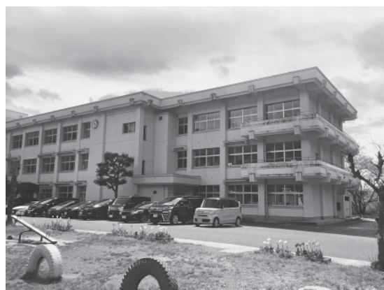
▲ 大規模改修される郡家東小学校
