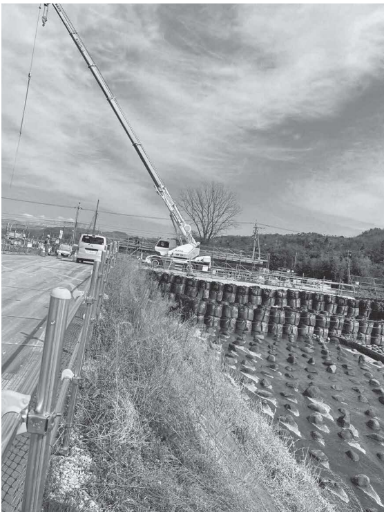
▲私都川改良工事現場
