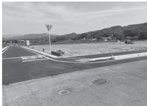
▲東郡家地区宅地造成
