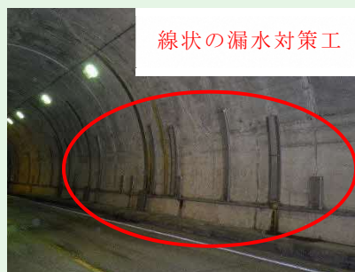
写真2.4 線状の漏水対策工の事例
