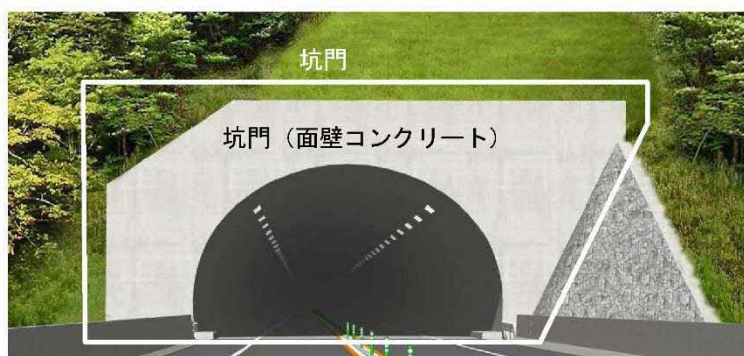
図4.1 トンネル本体工点検箇所
