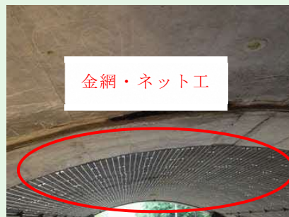
写真2.3 金網・ネット工の事例
