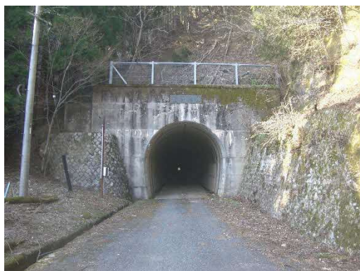
写真3.1 本谷トンネル状況写真
