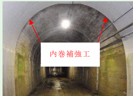
写真2.2 内巻補強工の事例
