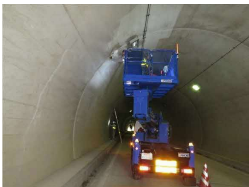
写真2.1 点検状況写真（トンネル定期点検）
