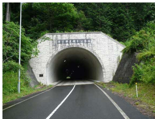
写真3.2 日下部見槻トンネル状況写真
