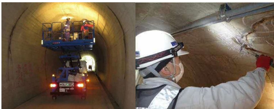
写真4.1 定期点検状況
