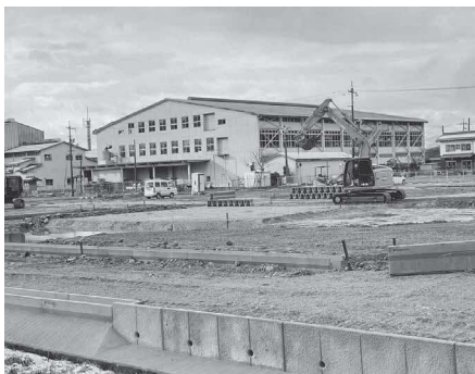
▲ 東郡家地区宅地造成
