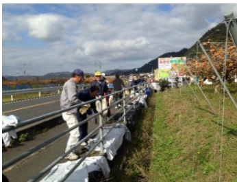
八頭町大門地内でのガードパイプ塗り作業
