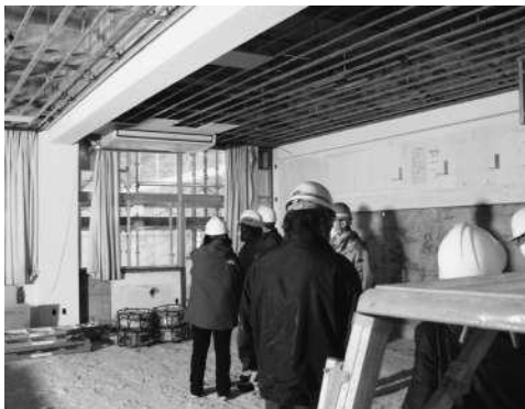
▲ 郡家西小学校の大規模改修現場視察調査 (令和3年11月24日)
