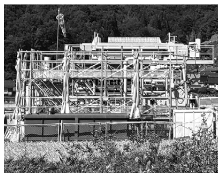
公共下水道竹ノ下排水区 雨水幹線工事現場(郡家保健センター前)
