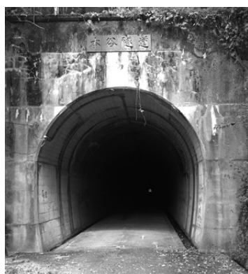
補修中の本谷トンネル（大江・志子部間）
