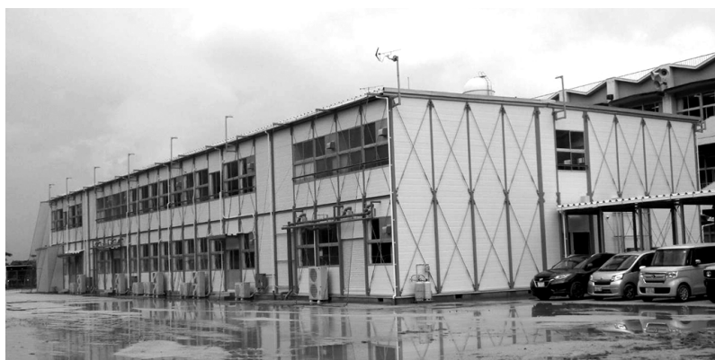
改修中の郡家西小学校
