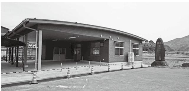
▲ 4月に完成した八東川水辺プラザ管理棟
