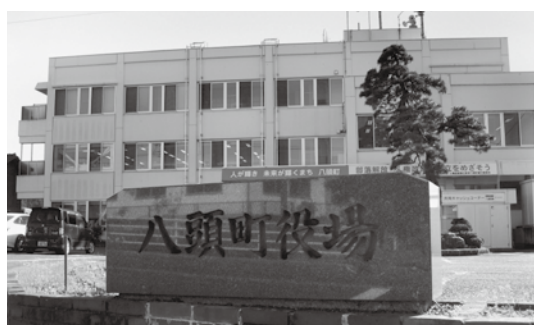
▲ 築51年経過した役場本庁舎
