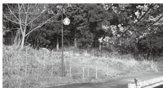
▲ 鳥獣侵入の防止柵設置が未整備 (八東総合運動公園)
