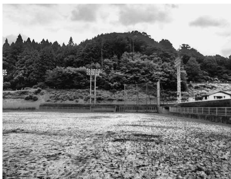
▲ホッケー場建設予定地 郡家運動場
