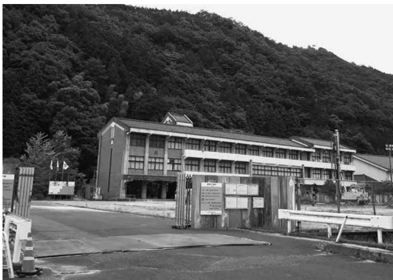
▲建設が進む（仮称）八東保育所
