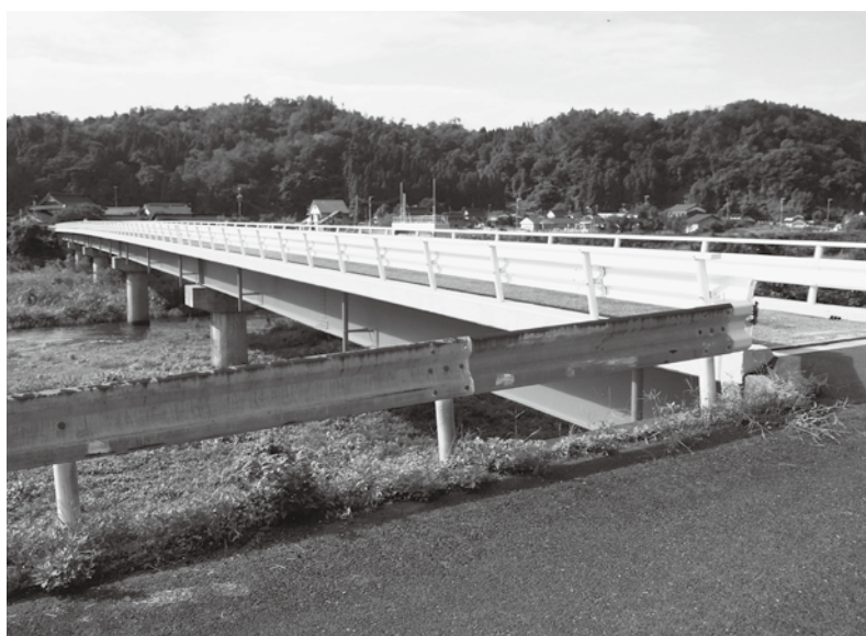
▲ 修繕が完了し、きれいになった石田橋
