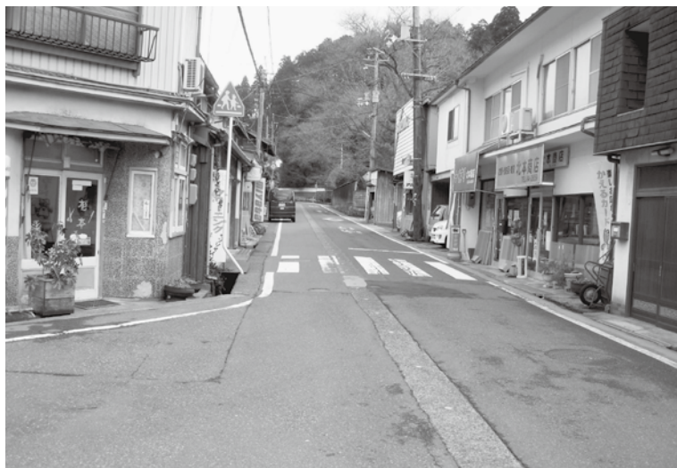
▲ 損傷の激しい県道（才代）
