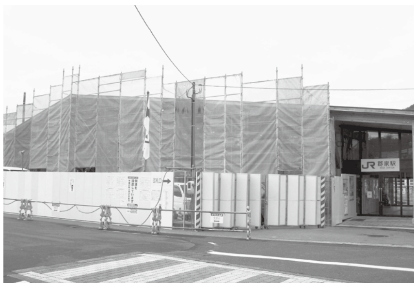
▲ 改装中の郡家駅
