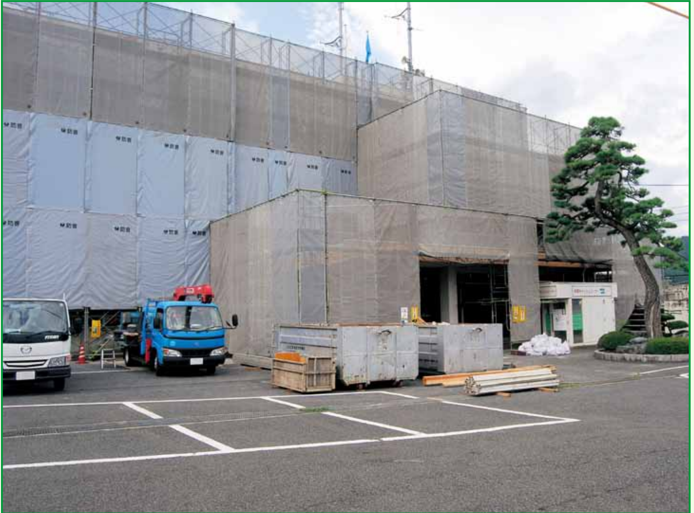
▲耐震改修工事中の本庁舎
