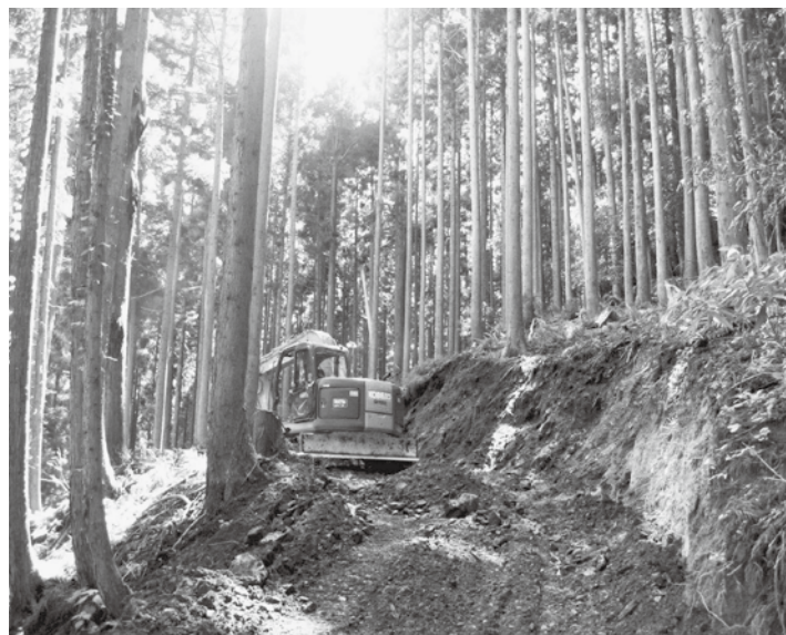
▲ 奥野・清徳・茂谷線作業道新設中
