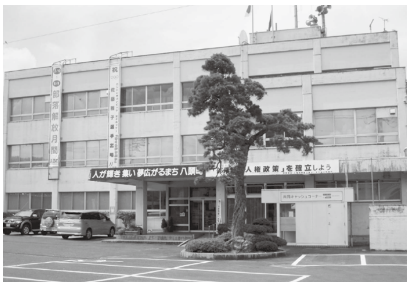
▲ 耐震工事が待たれる本庁舎
