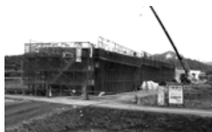
▲着々と工事が進む河原インター線
