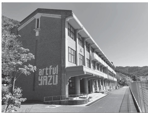
「あーとふる八頭」に改修された旧安部小学校
