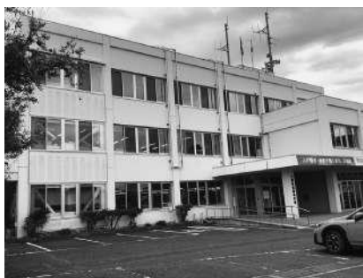
▲ 老朽化した本庁舎
