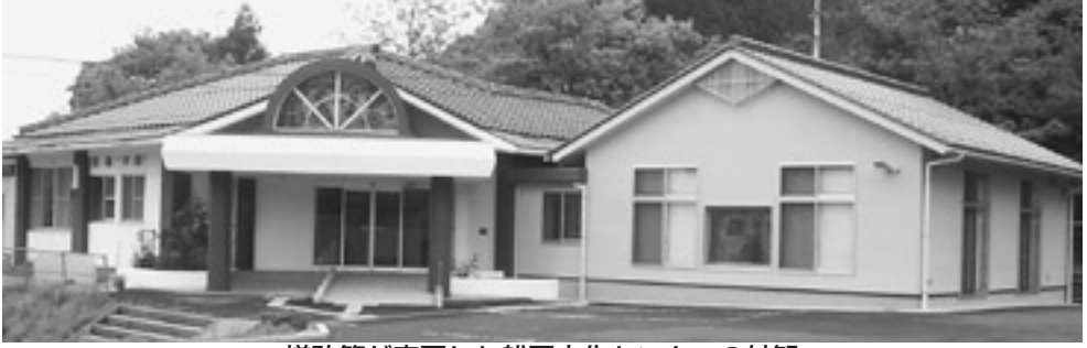
増改築が完了した船岡文化センターの外観
