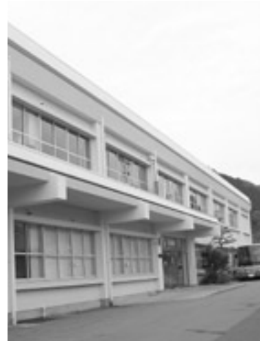
八東図書室の外観
