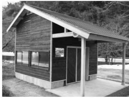
完成した休憩所の外観
