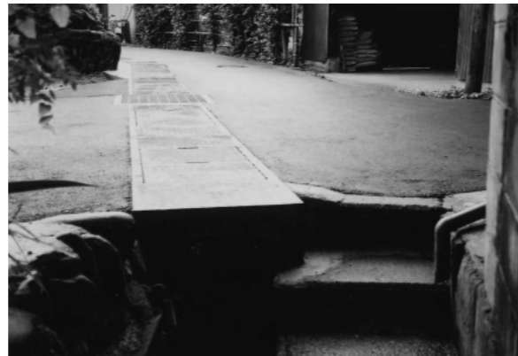
西御門地区水路改修工事
