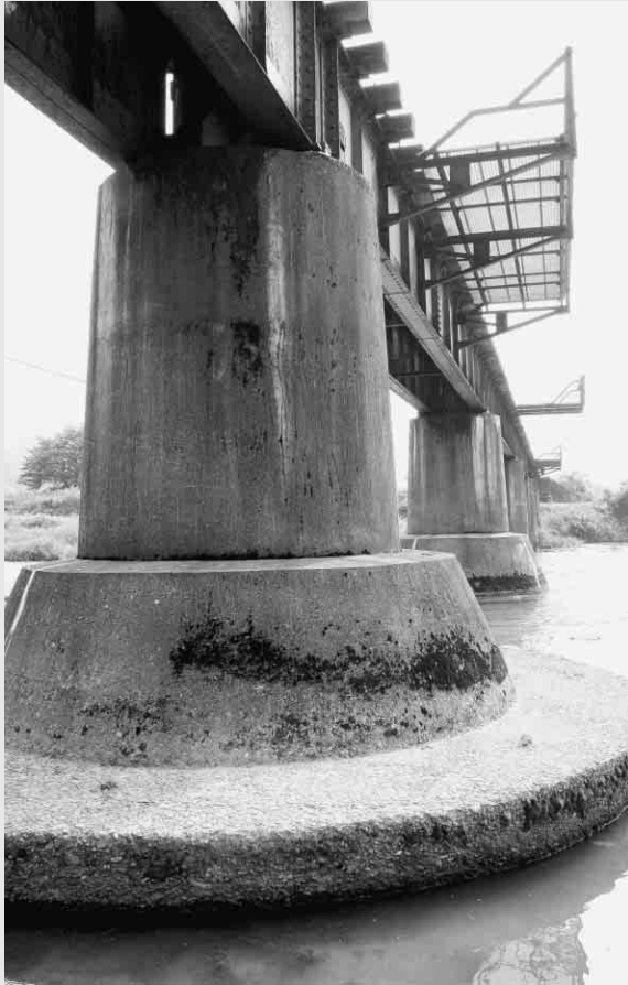
補強された橋脚下部
