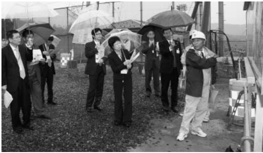
河原インター線工事現場
