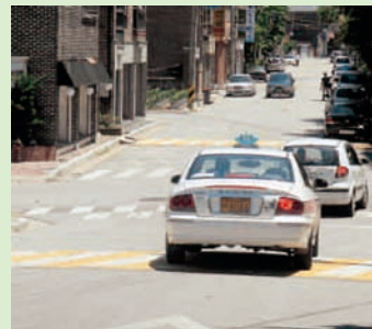
信号機のない交差点で減速させる突起物
