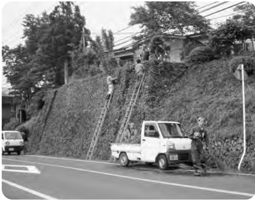
斜面をきれいに清掃作業
