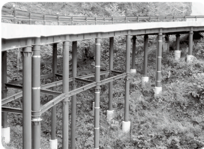
自然環境に配慮したメタルロード工法
