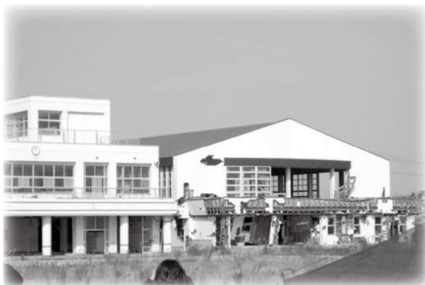
津波の被害にあった小学校
