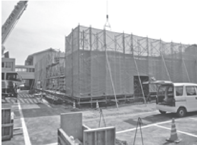
増築工事中の新中学校
