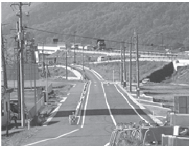
改良された町道下濃船久線
