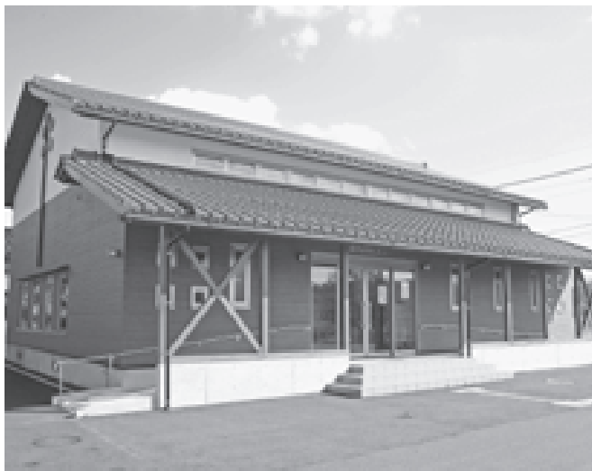
新築された国中活性化施設
