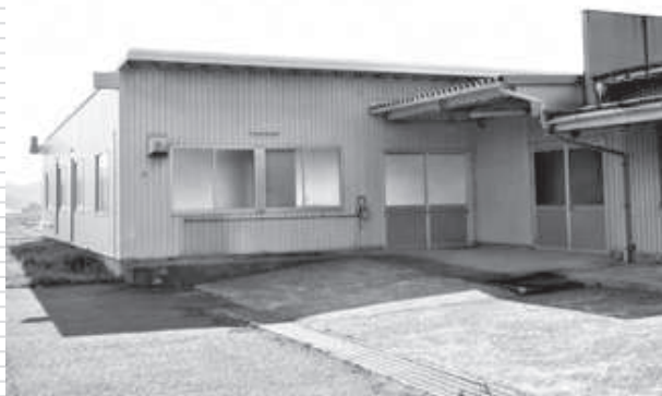
仮庁舎(三西電気化学工業(株)内) (八頭町郡家609番地2)
