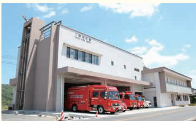
新庁舎が完成した八頭消防署
