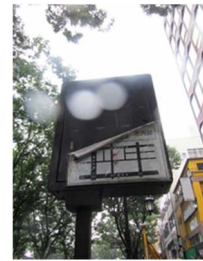
シート材がはがれかかった状態
