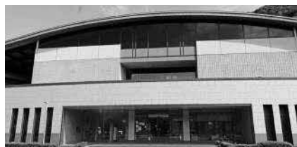
大規模改修を行った船岡保健センター
