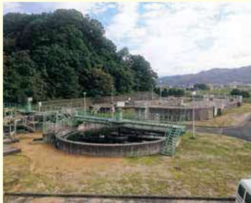
下水処理場（郡家浄化センター）
