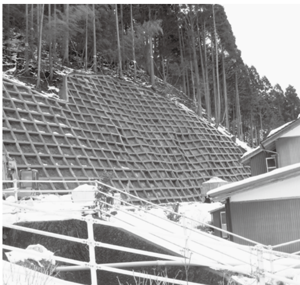
▲急傾斜地防災工事
