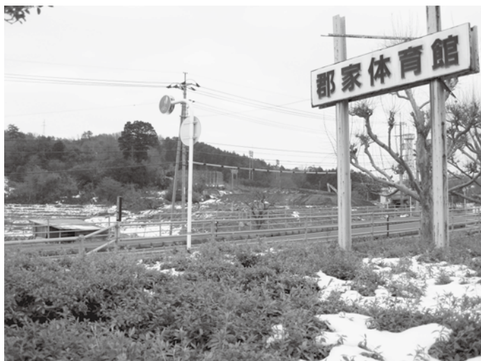
▲新中学校駐車場造成工事
