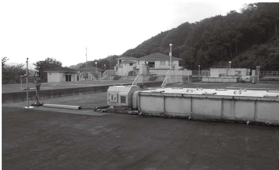
▲町公共下水道郡家浄化センター
