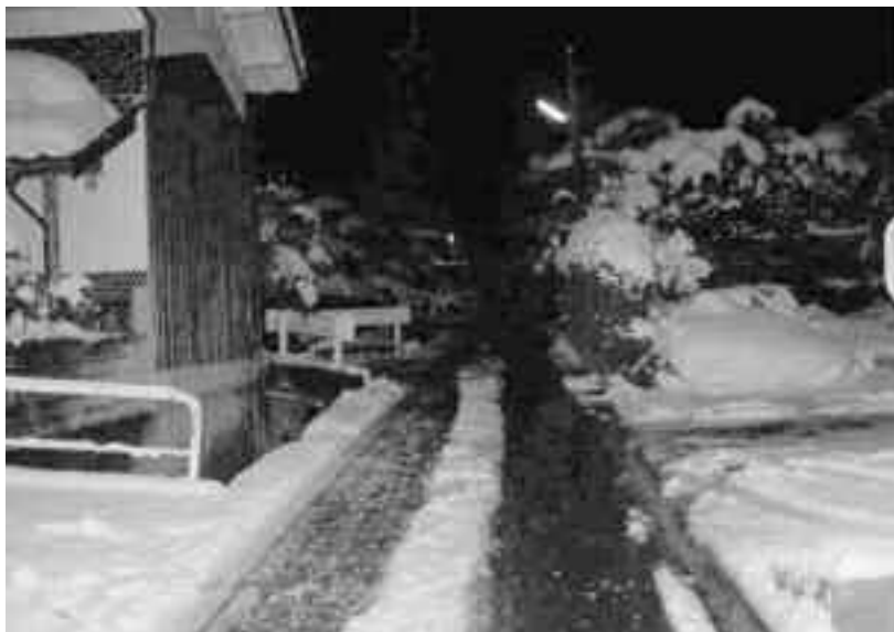
▲夜の雪道を照らす防犯灯
