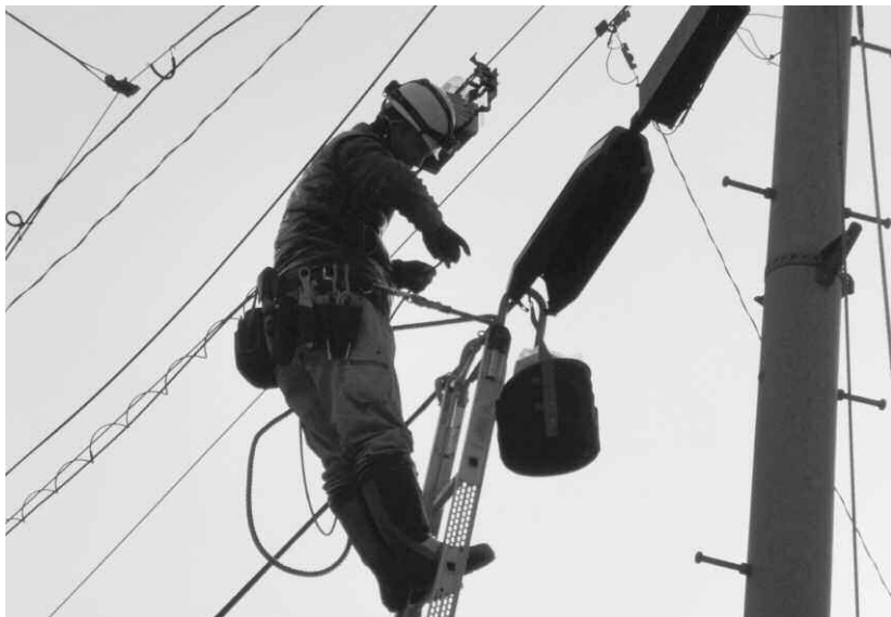
▲急ピッチで進む光ファイバー工事
