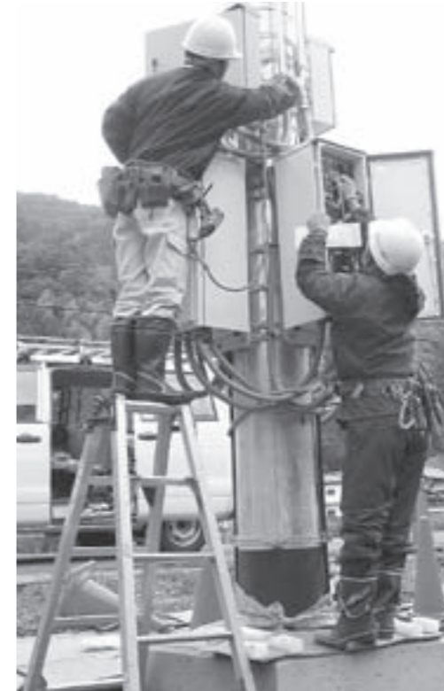
▲急ピッチで進む防災行政無線工事
