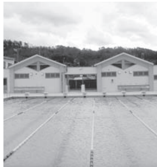
▲新設された中央中学校プール
