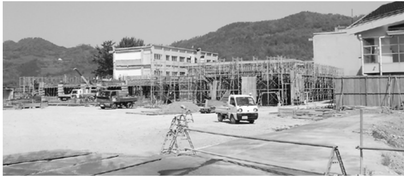
▲着々と建設が進む中央中学校
