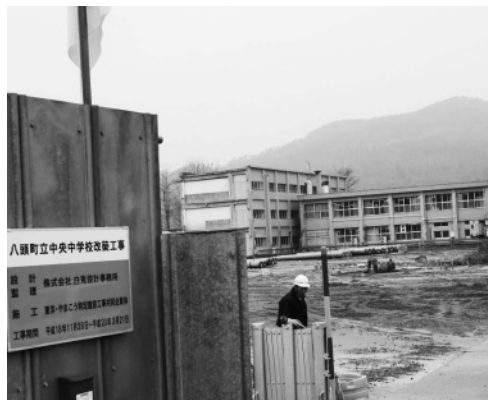
▲改築工事の進む中央中学校
