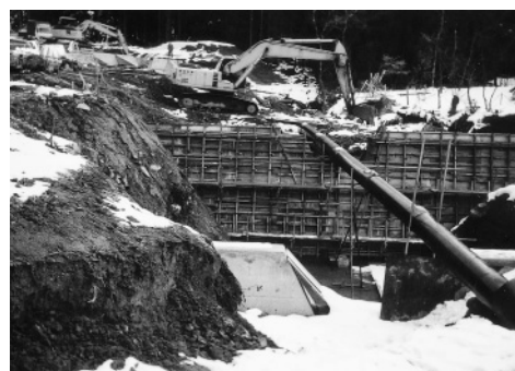
▲谷川の砂防工事
