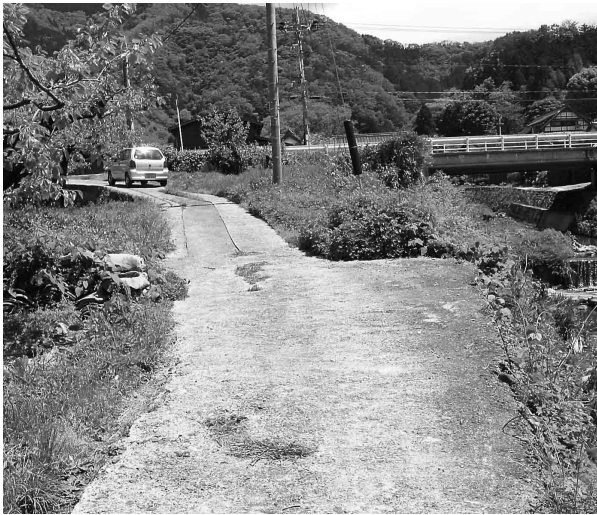
町道拡幅と水道管移設要望箇所（郡家殿地内）
