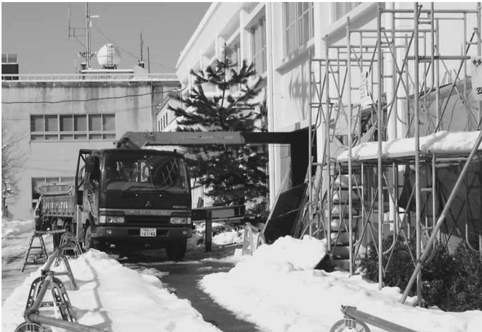
▲改修中の山村開発センター
