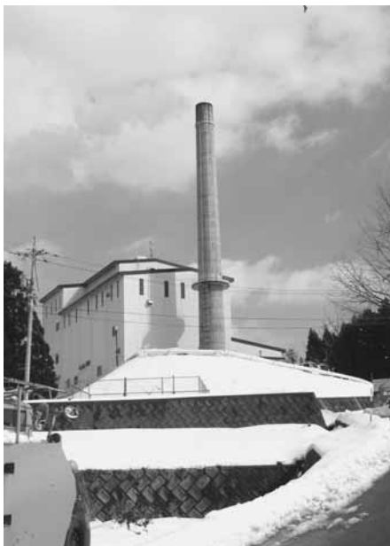
▲平成21年6月まで使用予定の クリーンセンターやず
