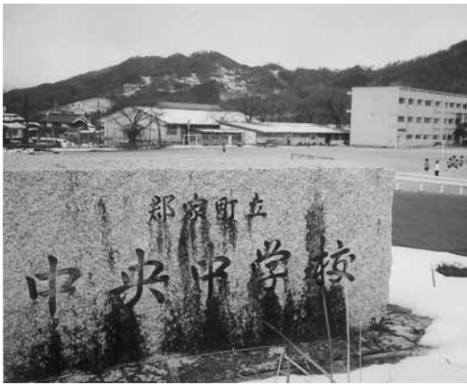
▲改築が検討されている中央中学校
